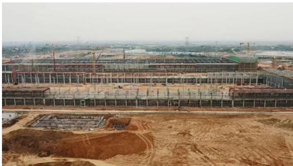
楚能新能源宜昌生产基地新建项目施工现场
