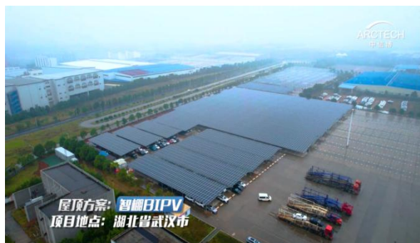
东风汽车武汉基地新建 BIPV 光伏车棚项目鸟瞰图
